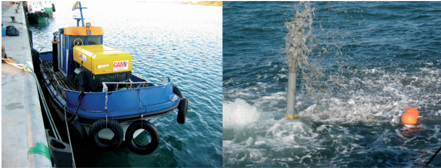
Compresor de aire para manga de succión. Y salida de sedimentos en superficie.
